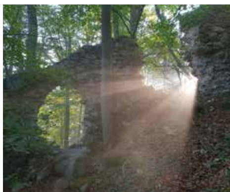
Loch in der Mauer
